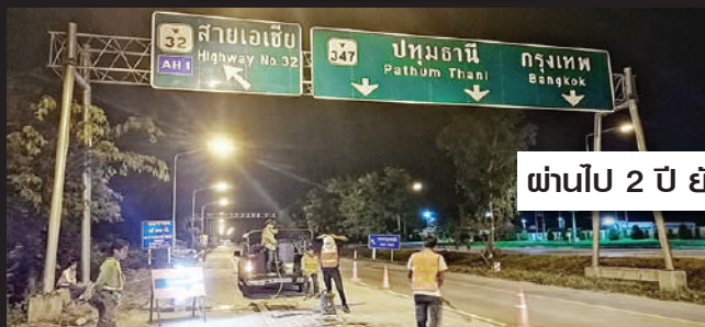
ถนนทางหลวง 347 ติดตั้ง ส.ค. 2562
