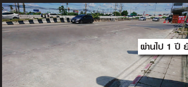
ถนน รัตนาริเบศร์ใกล้ Central westgate ติดตั้ง ม.ย. 2563
